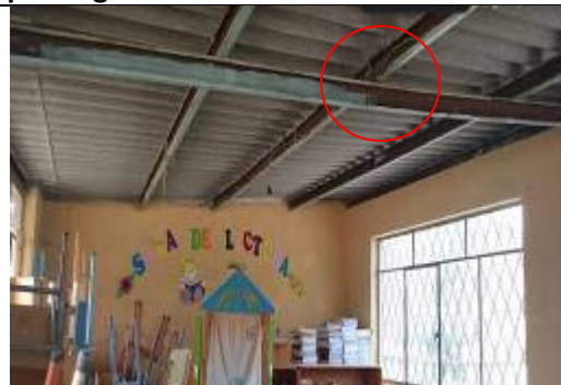
Foto 8: Estructura metálica corrosionada, bajantes y canales de recolección de agua lluvia rotos, cableado eléctrico remendado y en contacto con la estructura metálica.
