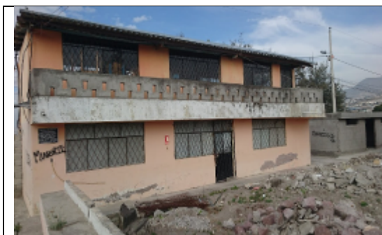
Foto 5: Mampostería externa con patologías debido a la humedad.
