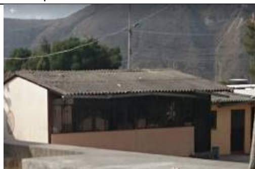
Foto 9: Cubierta de eternit rota, las partículas de asbesto se están desprendiendo.
