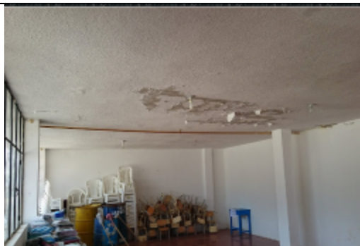
Foto 13: Humedad en losa, produciendo pequeñas deflexiones en la losa.
