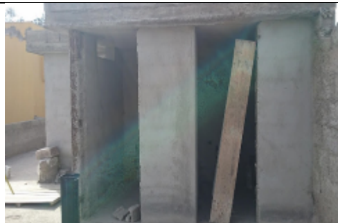
Foto 35: Baños sin tubería de abastecimiento de agua potable, sin inodoros y sin puertas.
