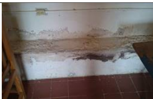
Foto 6: Mampostería interna con patologías debido a la humedad.
