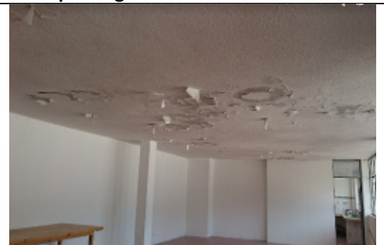
Foto 14: Humedad en losa y puntos de luz inhabilitados.
