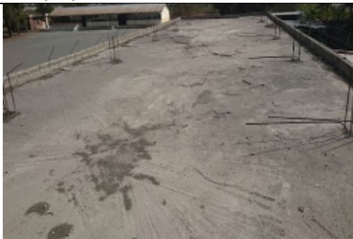
Foto 15: Acumulación de sedimentos y microfisuración en losa de cubierta
