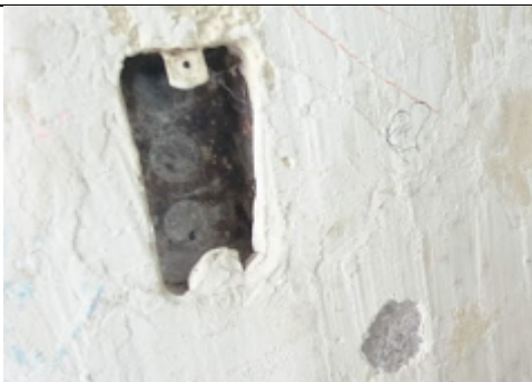
Foto 11: Cajetines de puntos de control sin interruptores
