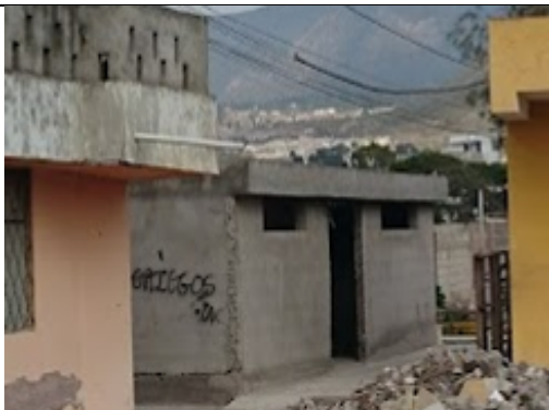
Foto 32: Bloque de batería sanitaria sin terminar en obra gris.
