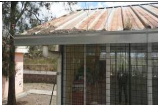
Foto 17: Acumulación de sedimentos y crecimiento de materia orgánica en canales de descarga de agua lluvia.
