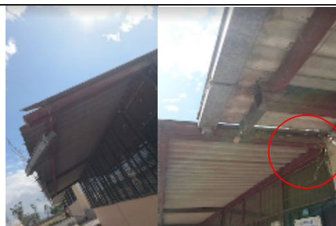
Foto 2: Estructura metálica corrosionada, bajantes y canales de recolección de agua lluvia rotos, cableado eléctrico remendado.
