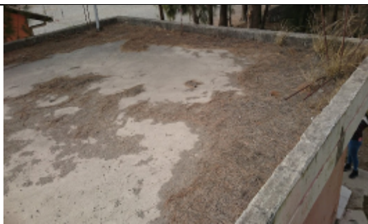
Foto 31: Acumulación de sedimento, crecimiento de materia orgánica y microfisuración en losa de cubierta.
