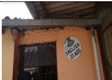
Foto 4: Bajantes y canales de recolección de agua lluvia rotos.
