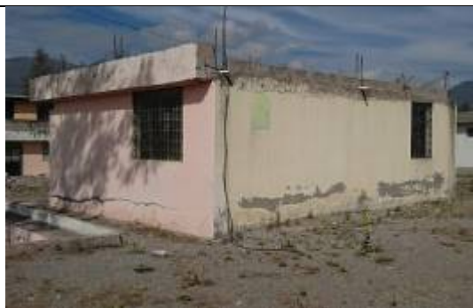
Foto 9: Mampostería y losa externa con patologías debido a la humedad.
