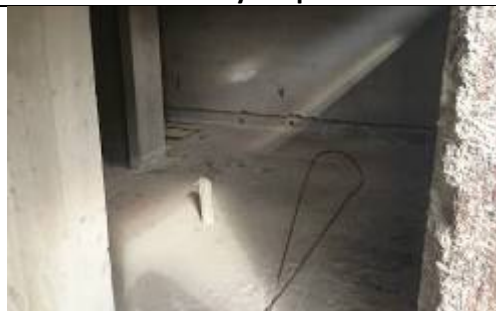
Foto 37: Baños sin trampas de piso para evacuar aguas negras y lluvias.
