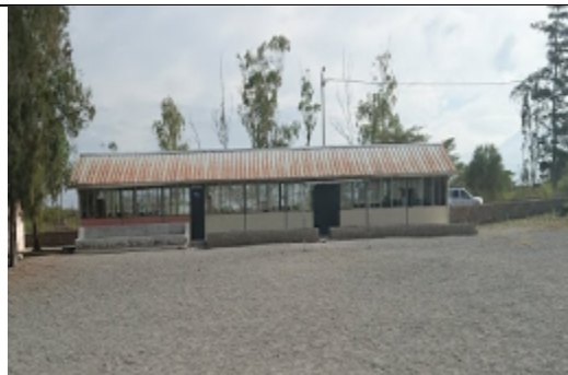
Foto 16: Corrosión en cubierta de galvalume.
