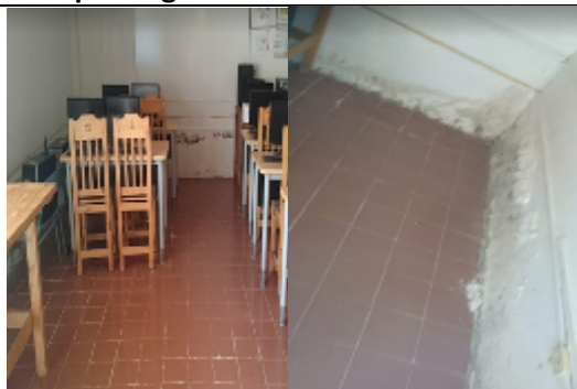
Foto 7: Mampostería interna con patologías debido a la humedad.
